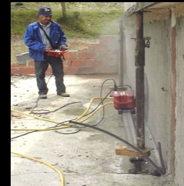
Rupture nette entre zone à démolir et construction
